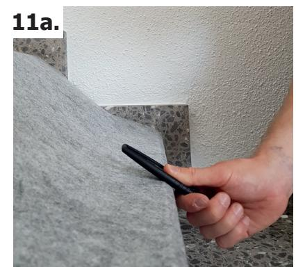
Свежее полотно заламывайте на углах лестницы тупым предметом добиваясь хорошего облегания с надёжным прилипанием.
