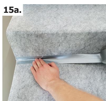
Если защитное покрытие планируется использовать интенсивно и долго, следует усилить стыки липкой лентой.
