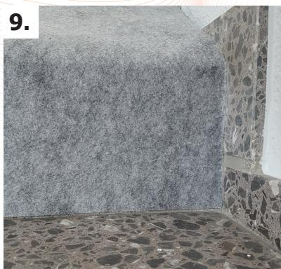
Нижний край покрытия разместите точно по углу ступеньки, а край строго вдоль стены.
