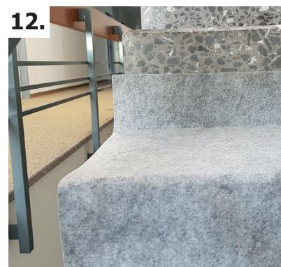
ALLPROTECT должен выходить за габариты лестницы, чтобы потёки пролитых жидкостей не оставляли следов.
